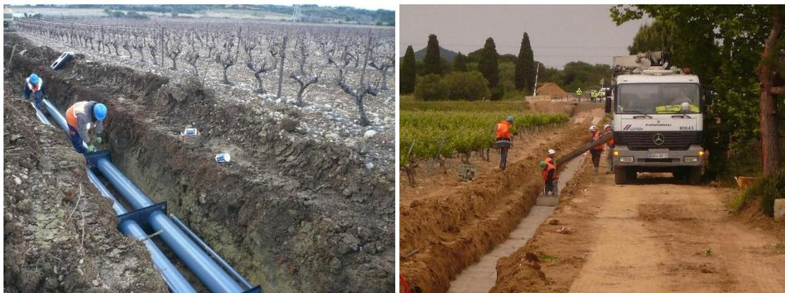
Photos de la pose du génie civil d'une liaison souterraine en fourreaux PVC\* (liaison Baixas – Santa Llogaïa)
